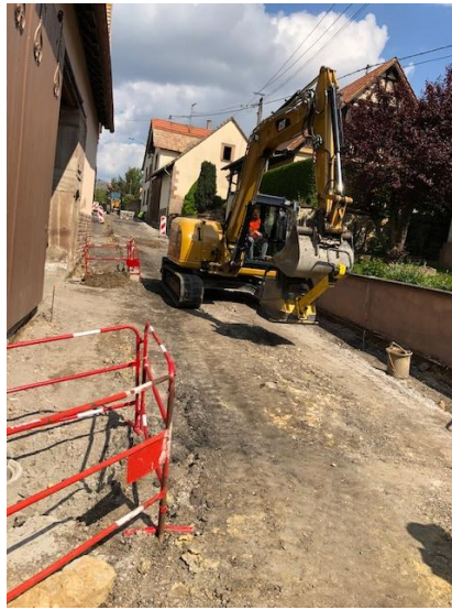
Travaux en cours rue Traversière
