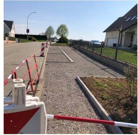
Travaux en cours rue du Faubourg
